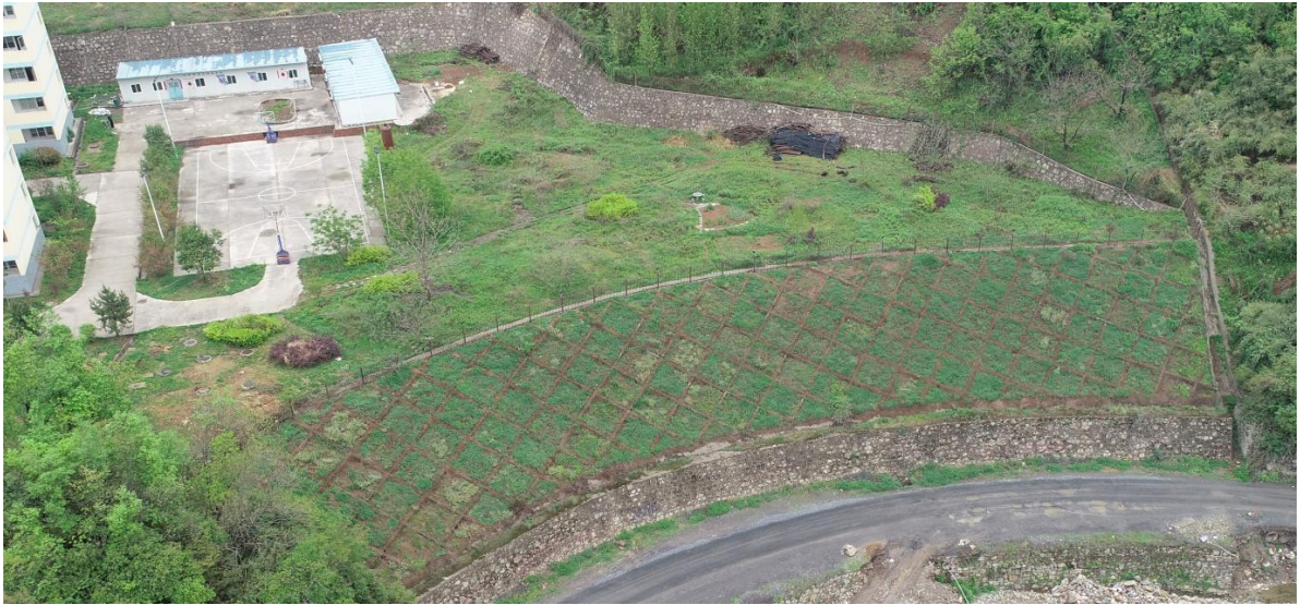
照片 2-15 生活区复垦工程效果（镜像 320°）
