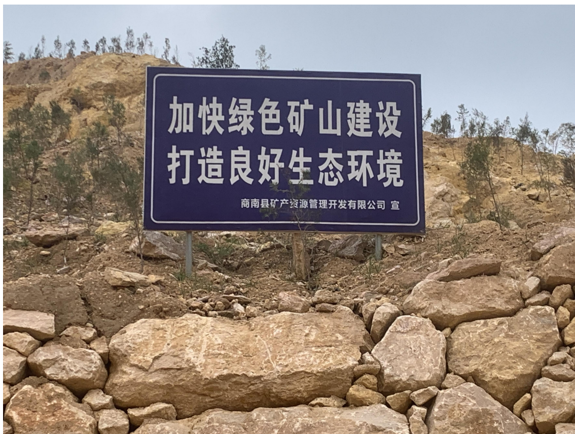
照片 2-6 K2 边坡治理后（2021 年度）
