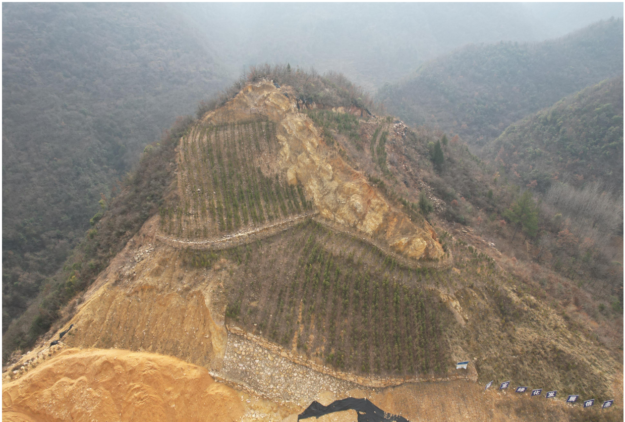
照片 2-10 K2 边坡治理后（2023 年度）
