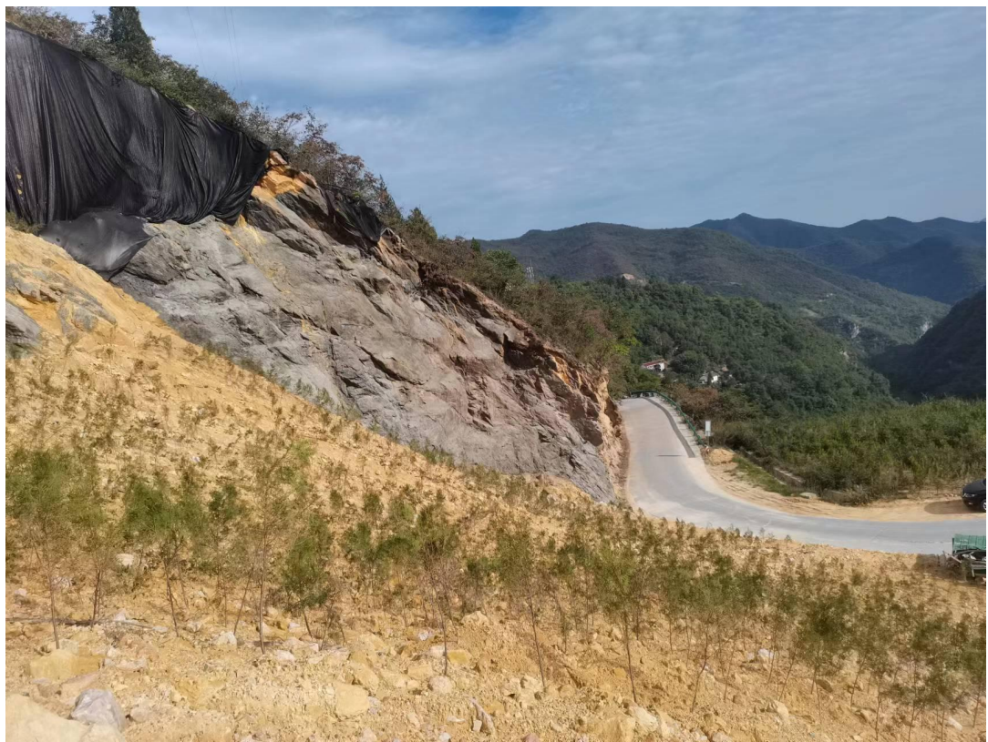
照片 2-9 K1 边坡治理后（2022 年度）
