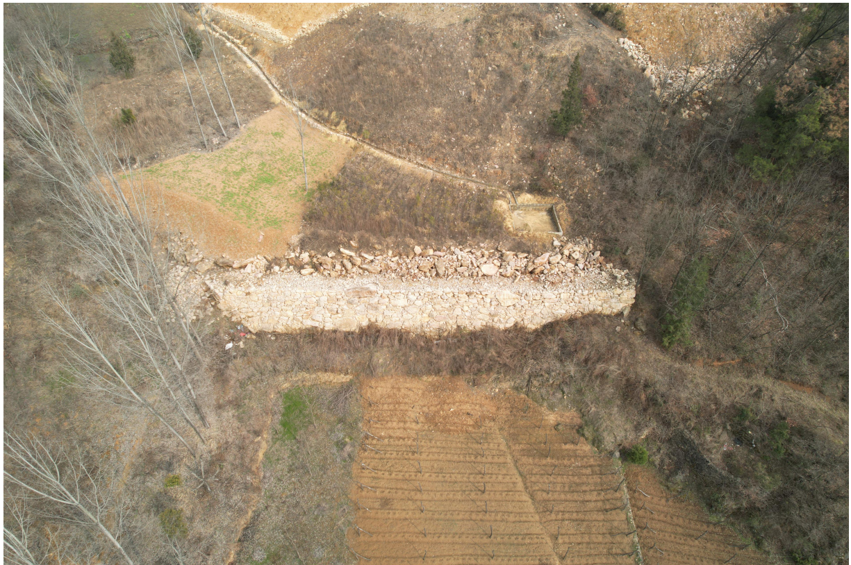
照片 2-11 K2 矿体挡墙及排水渠（2023 年度）
