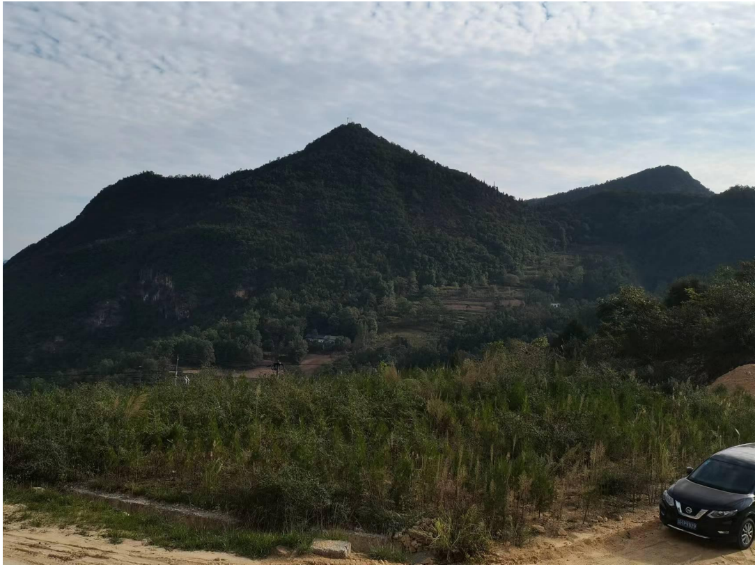
照片 2-8 K1 边坡治理后（2022 年度）
