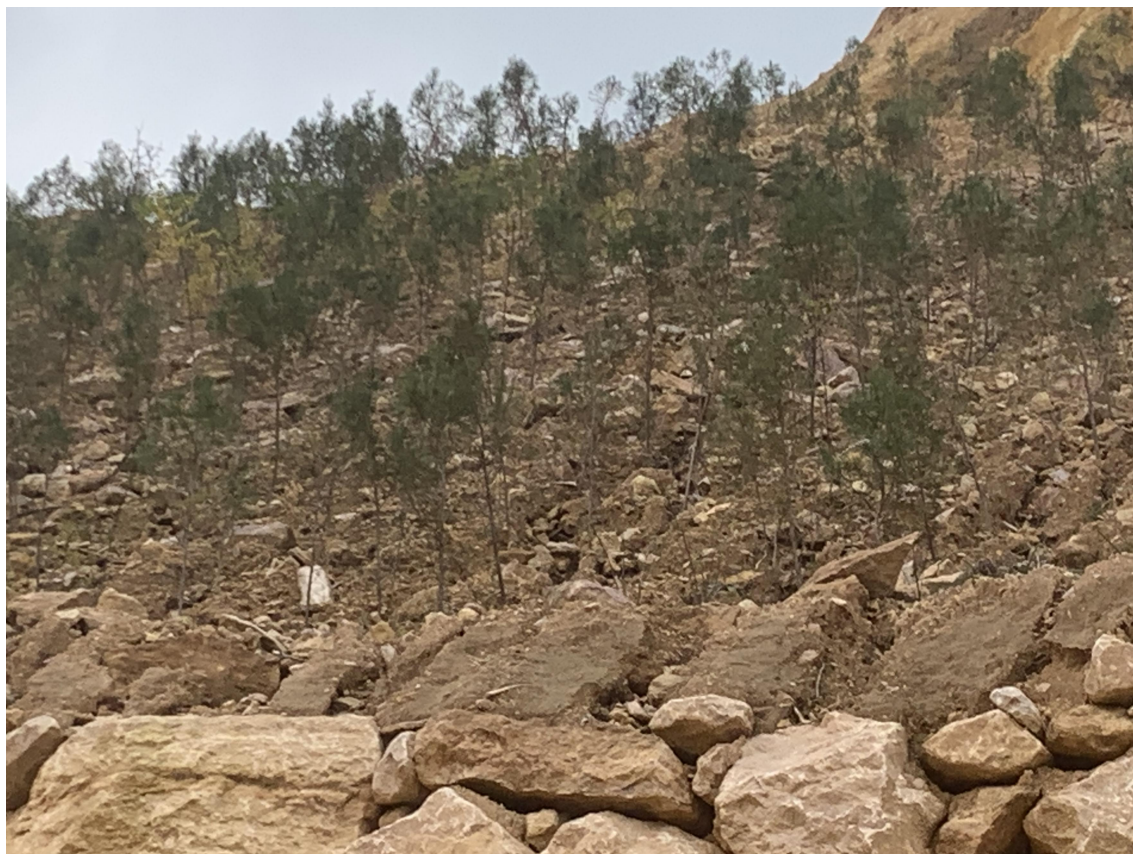
照片 2-7 K2 边坡治理后（2021 年度）
